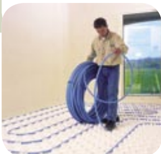
PEX buizen, behandeld door elektronenbundels, worden vrij veelvuldig gebruikt in vloerverwarmingssystemen.
